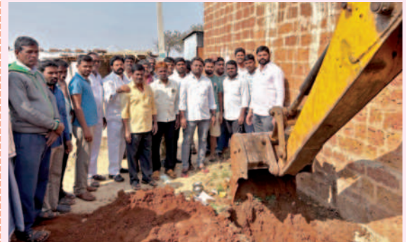
మురుగుకాల్వల నిర్మాణానికి శ్రీకారం మడుతున్న సర్పంచి పీటర్ రాజు
